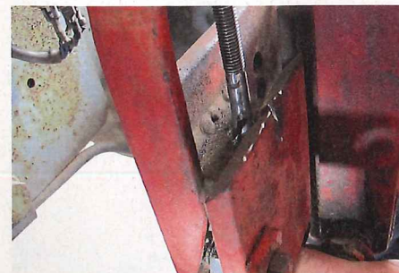
... sind ersetzt worden. Schweißen und auch Schleifen waren dazu nötig. Feder auf den Bolzen, von unten durchstecken, mit einem ...
