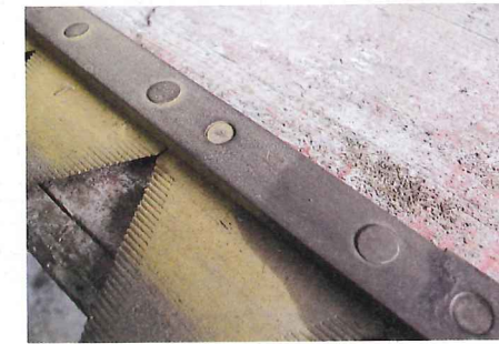
... einer Drahtbürste zu entfernen. Niete, die nicht herausragen, sind oft nicht ordentlich verschlagen, sprich, die Klinge ist lose. Wer ...
