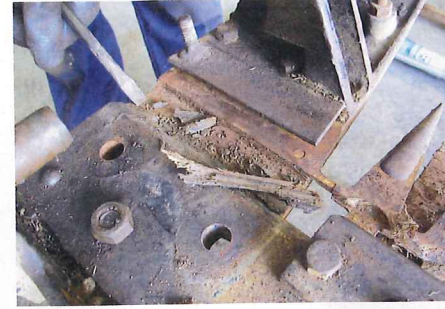
... kann die nächste der Flachkopfschrauben herausfallen (notfalls mit Hilfe eines leichten Hammerschlags). Mit einem Flachschar ...
