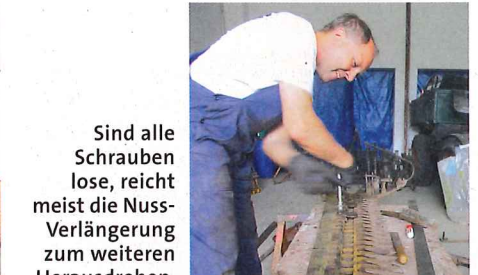
Looser Rost und Schmutz kann mit einem Stemmeisen oder Stechbeitel entfernt werden
