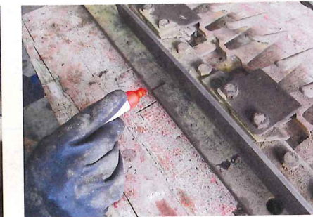
... oder Böschungen gekommen sein – oder durch die Jahre. Anhand der aufgelegten Schiene lässt sich der Bereich markieren, der gerichtet ...
