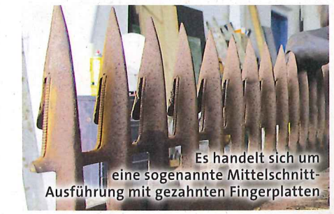
Bis auf die Finger und den Innenschuh ist der Balken nun von allem befreit. Die Finger sind als Doppelfinger ausgeführt, der dritte Finger ist ein Einzelfinger
