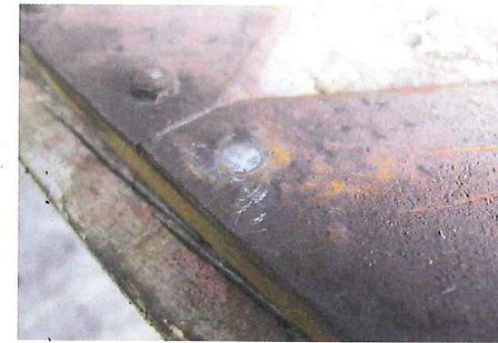
... nicht mehr fest sind. Die entsprechenden Niete werden dann mit Hammer und Meißel abgeschert und mit einem Austreiber aus ...
