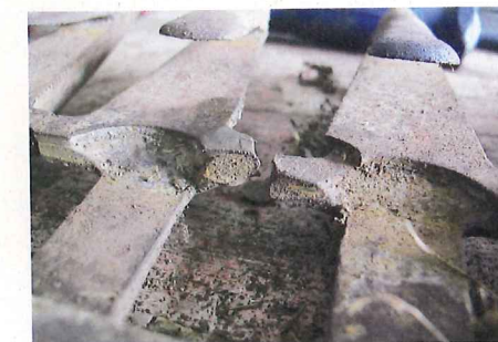
„Rückblick“ auf die Finger: Hier sind ebenfalls die Verbindungsflügel beschädigt, ein Stück der auswechselbaren Fingerplatte ist sogar ...
